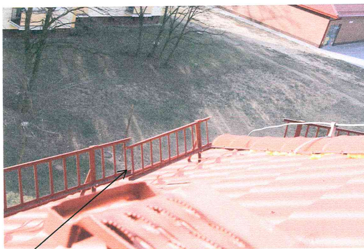
Brak mocowanie płotka przeciwśnieżnego
